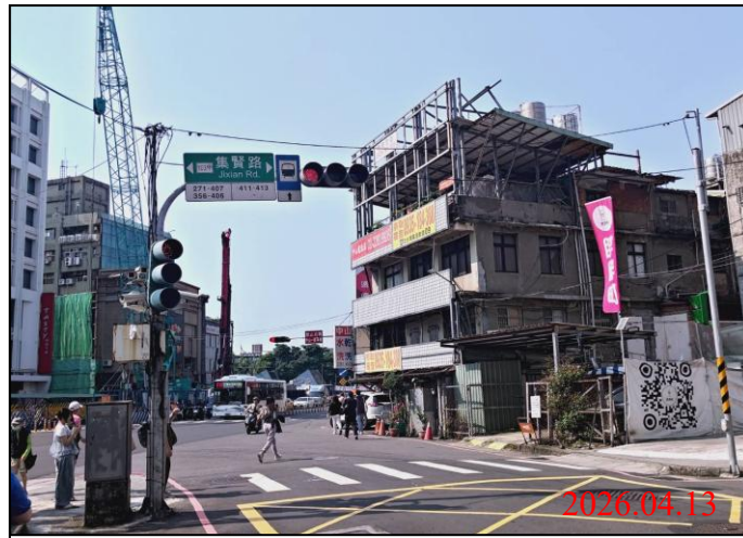
巡查日期地點：115.04.13/ Y21車站 照片說明：牌面設置狀況
