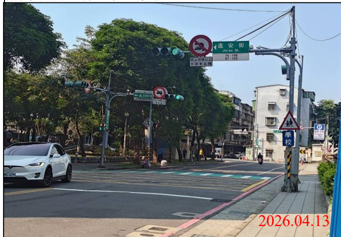
巡查日期地點：115.04.13/ Y23車站 照片說明：牌面設置狀況
