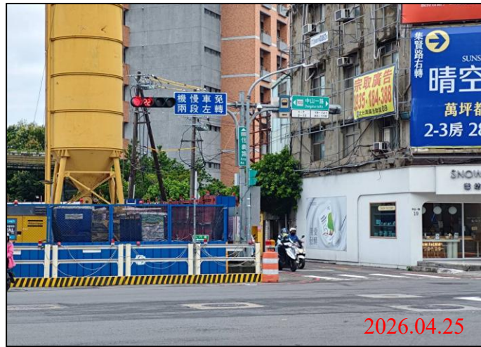
巡查日期地點：115.04.25/ Y21車站 照片說明：牌面設置狀況
