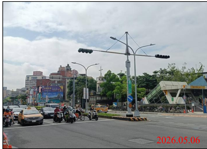
巡查日期地點：115.05.06/ Y21車站 照片說明：牌面設置狀況
