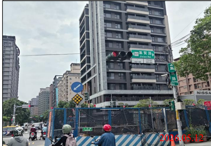
巡查日期地點：115.05.12/ Y22車站 照片說明：牌面設置狀況
