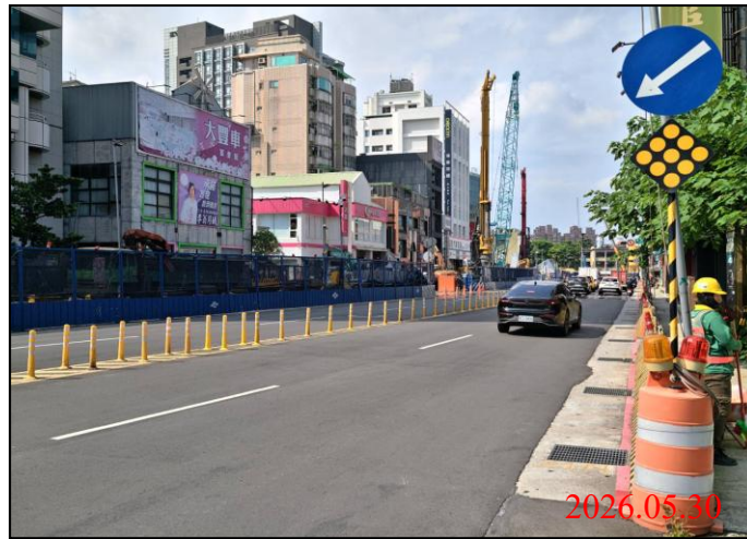
巡查日期地點：115.05.30/ Y21車站 照片說明：牌面設置狀況
