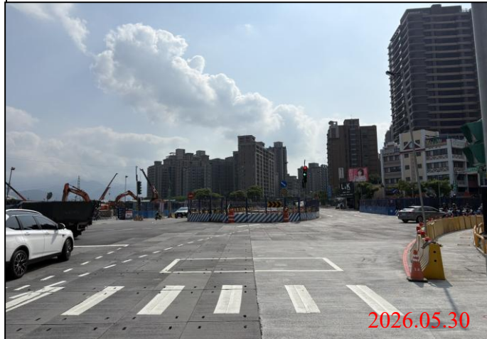
巡查日期地點：115.05.30/ Y22車站 照片說明：牌面設置狀況
