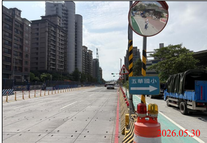
巡查日期地點：115.05.30/ Y23車站 照片說明：牌面設置狀況
