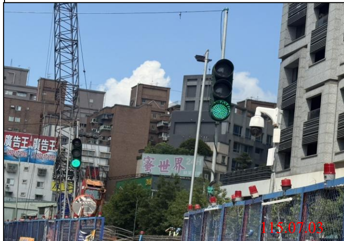
巡查日期地點：115.07.03/ Y22車站 照片說明：牌面設置狀況
