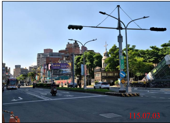
巡查日期地點：115.07.03/ Y21車站 照片說明：牌面設置狀況
