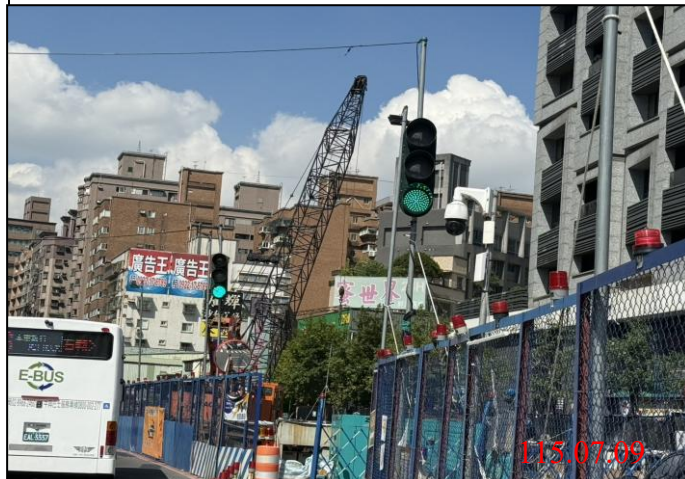
巡查日期地點：115.07.09/ Y22車站 照片說明：牌面設置狀況
