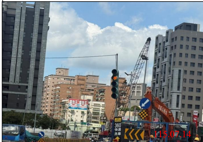
巡查日期地點：115.07.14/ Y22車站 照片說明：牌面設置狀況
