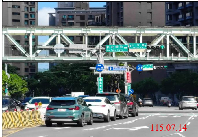
巡查日期地點：115.07.14/ Y23車站 照片說明：牌面設置狀況
