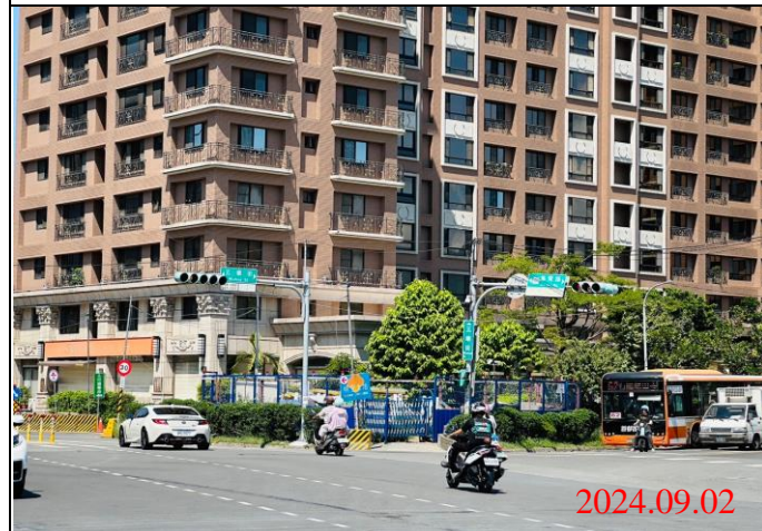
巡查日期地點：113.09.02/ Y22車站 照片說明：牌面設置狀況
