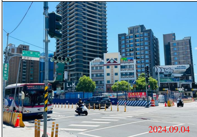
巡查日期地點：113.09.04/ Y22車站 照片說明：牌面設置狀況
