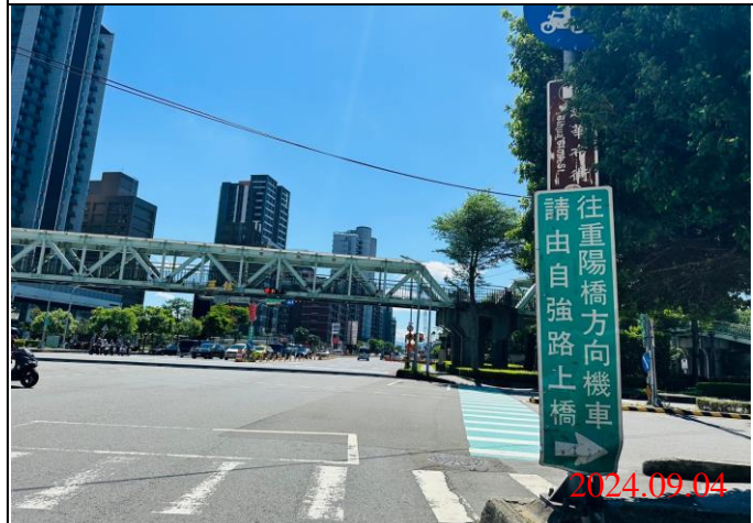
巡查日期地點：113.09.04/ Y23車站 照片說明：牌面設置狀況
