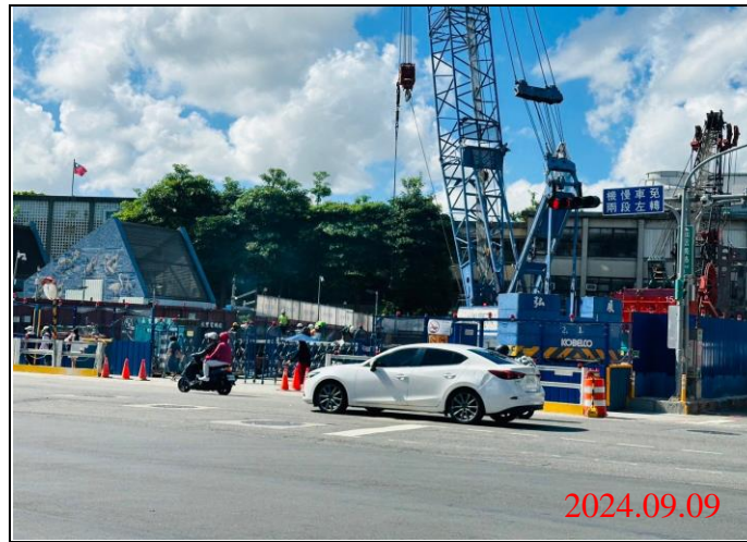
巡查日期地點：113.09.09/ Y21車站 照片說明：牌面設置狀況
