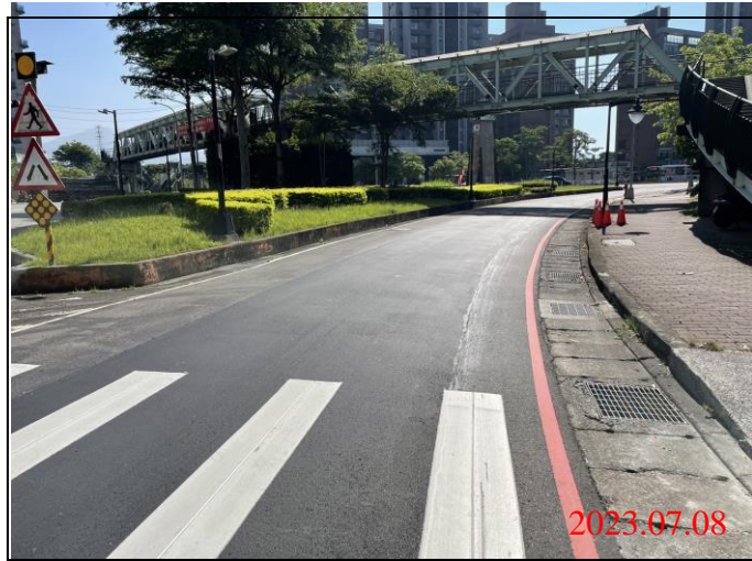
巡查日期地點：112.07.08/ Y23車站 照片說明：路面狀況
