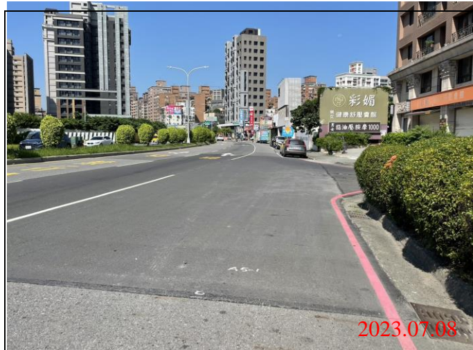
巡查日期地點：112.07.08/ Y22車站 照片說明：路面狀況
