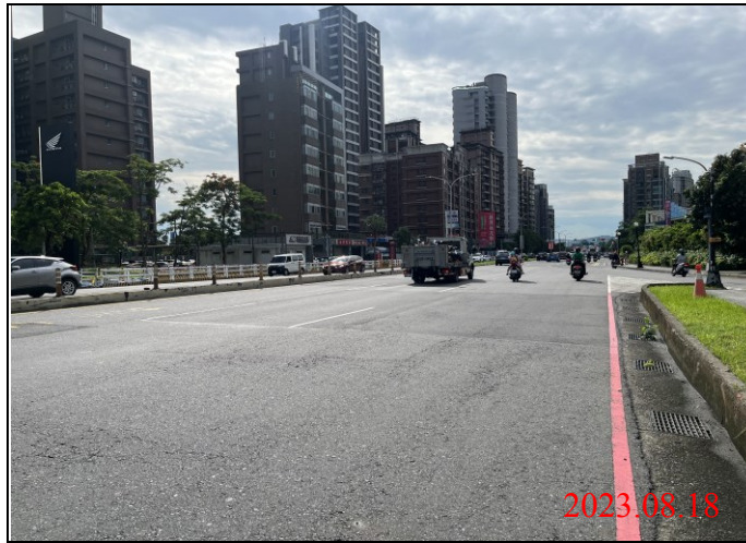
巡查日期地點：112.08.18/ Y23車站 照片說明：路面狀況
