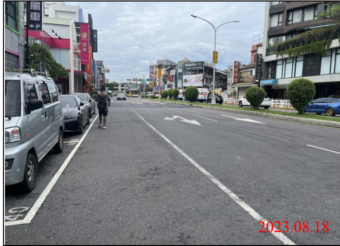
巡查日期地點：112.08.18/ Y21車站 照片說明：路面狀況
