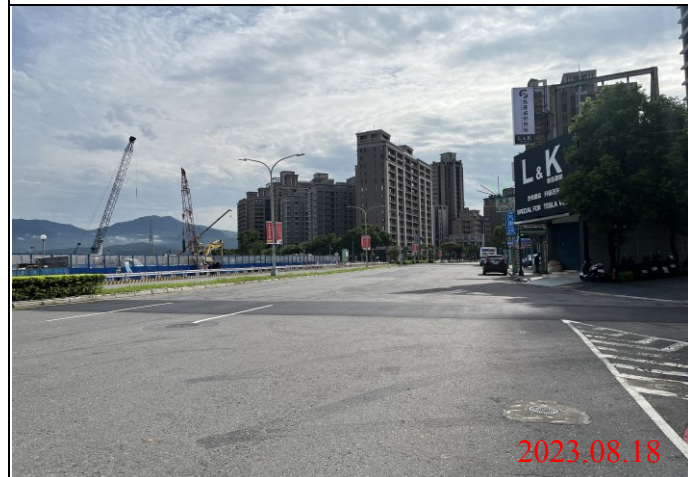
巡查日期地點：112.08.18/ Y22車站 照片說明：路面狀況
