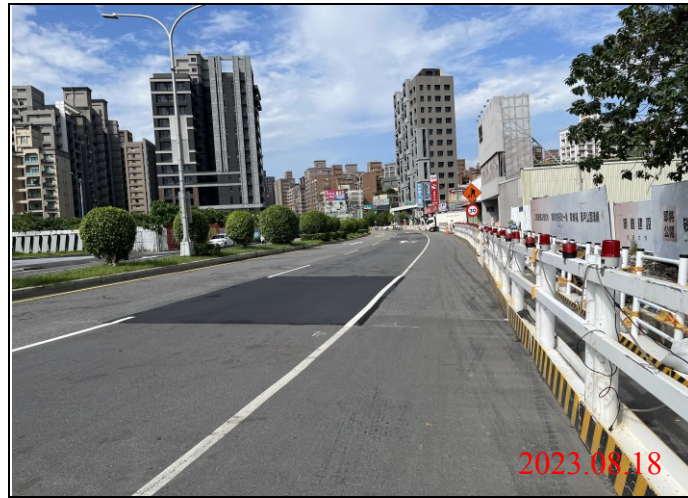
巡查日期地點：112.08.18/ Y22車站 照片說明：路面狀況
