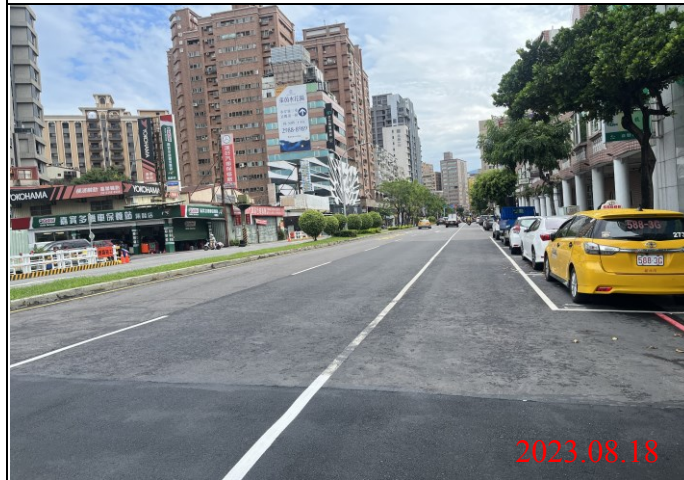
巡查日期地點：112.08.18/ Y21車站 照片說明：路面狀況
