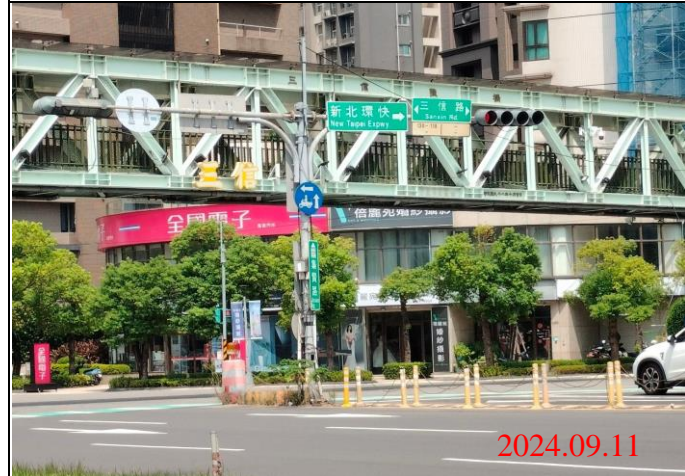
巡查日期地點：113.09.11/ Y23車站 照片說明：牌面設置狀況
