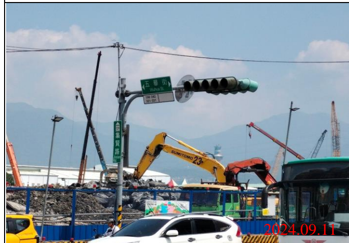
巡查日期地點：113.09.11/ Y22車站 照片說明：牌面設置狀況
