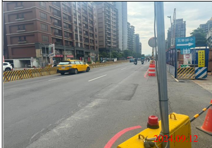
巡查日期地點：113.09.12/ Y23車站 照片說明：牌面設置狀況
