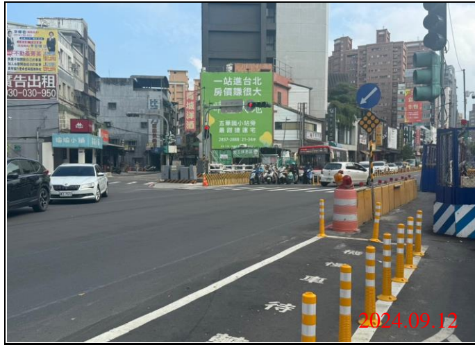
巡查日期地點：113.09.12/ Y21車站 照片說明：牌面設置狀況
