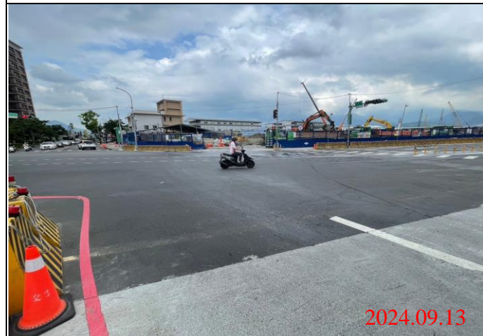
巡查日期地點：113.09.13/ Y22車站 照片說明：牌面設置狀況
