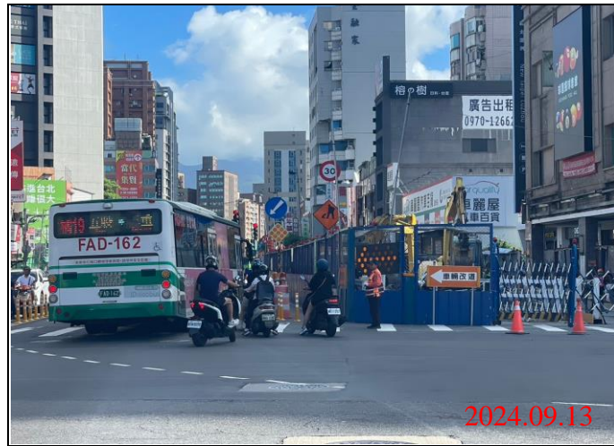
巡查日期地點：113.09.13/ Y21車站 照片說明：牌面設置狀況
