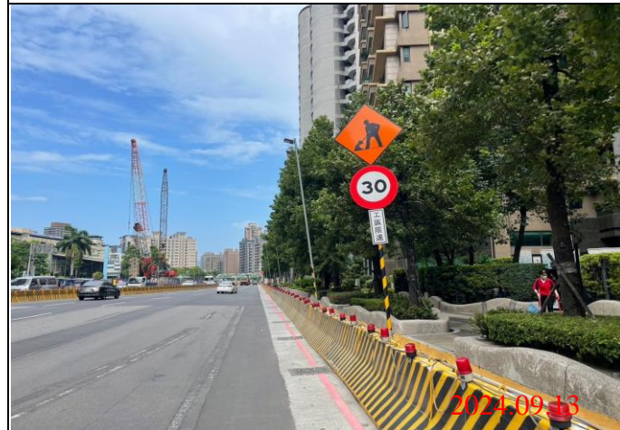
巡查日期地點：113.09.13/ Y23車站 照片說明：牌面設置狀況
