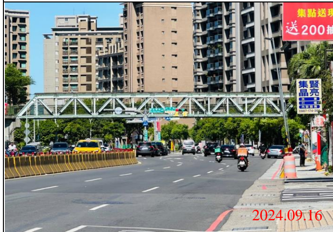
巡查日期地點：113.09.16/ Y23車站 照片說明：牌面設置狀況
