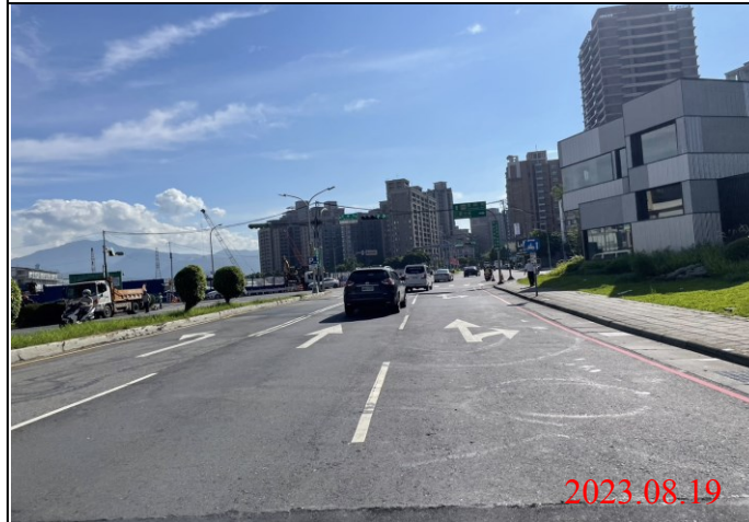
巡查日期地點：112.08.19/ Y22車站 照片說明：路面狀況
