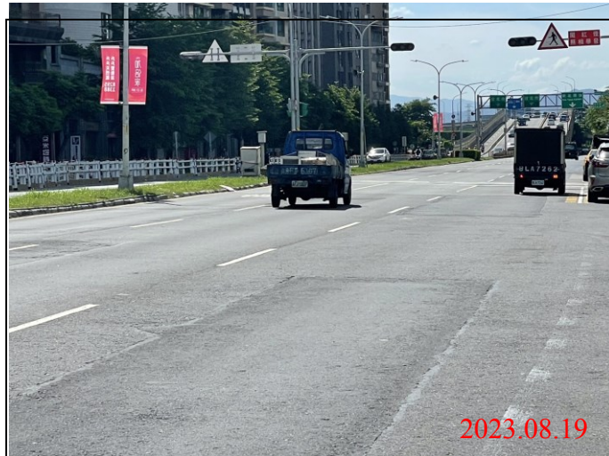
巡查日期地點：112.08.19/ Y23車站 照片說明：路面狀況
