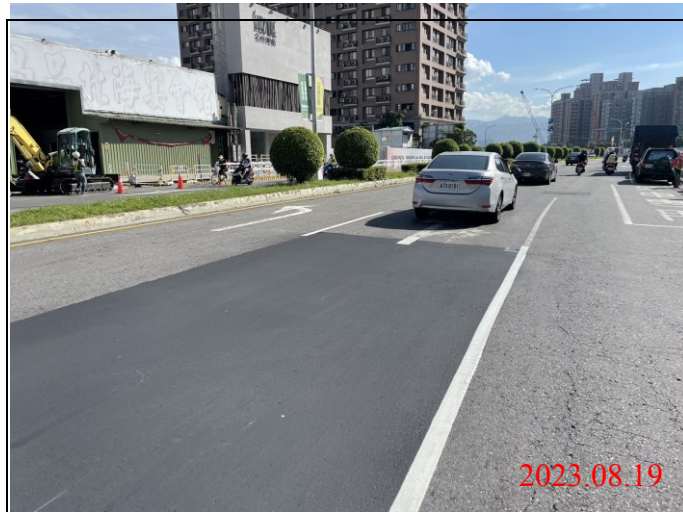
巡查日期地點：112.08.19/ Y21車站 照片說明：路面狀況
