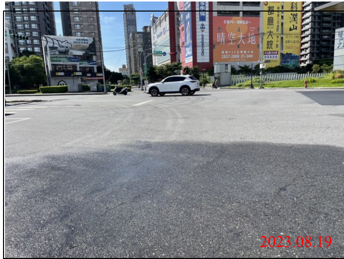
巡查日期地點：112.08.19/ Y22車站 照片說明：路面狀況
