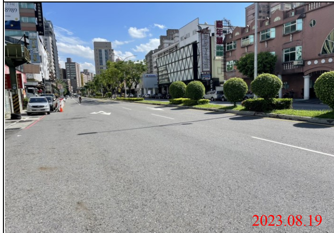
巡查日期地點：112.08.19/ Y21車站 照片說明：路面狀況
