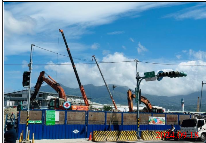
巡查日期地點：113.09.18/ Y22車站 照片說明：牌面設置狀況
