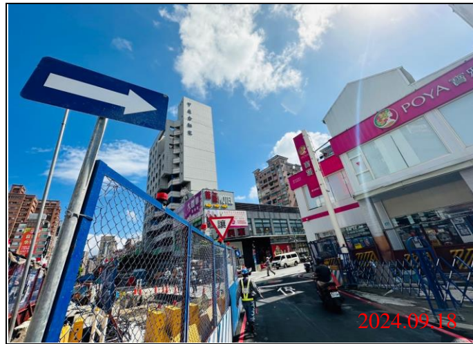
巡查日期地點：113.09.18/ Y21車站 照片說明：牌面設置狀況
