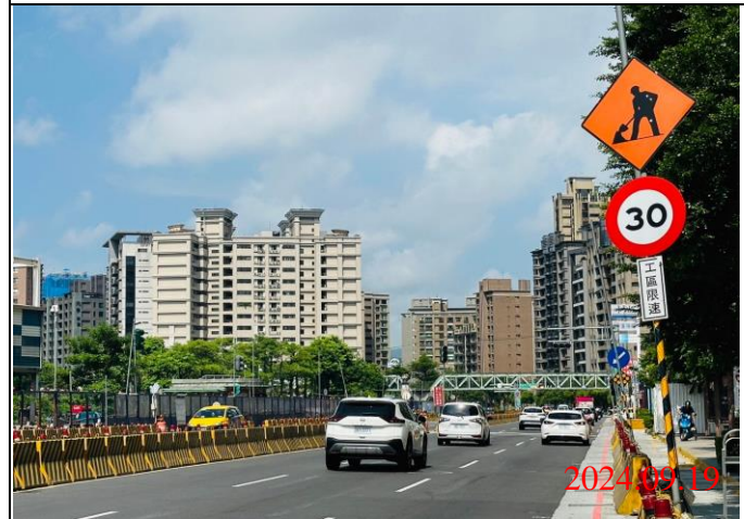
巡查日期地點：113.09.19/ Y23車站 照片說明：牌面設置狀況
