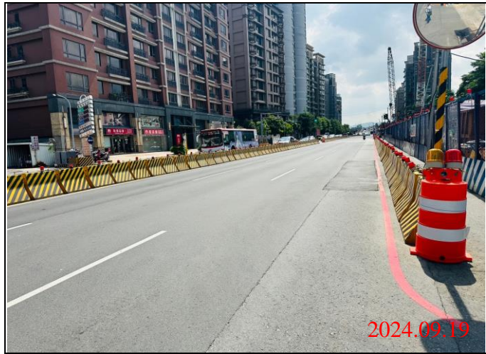
巡查日期地點：113.09.19/Y23車站 照片說明：路面狀況
