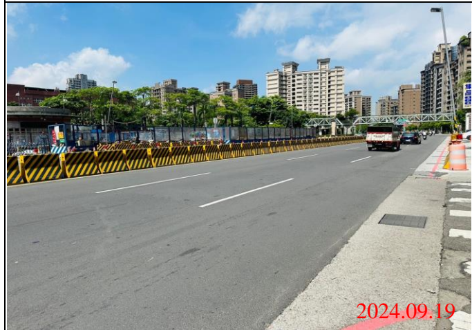
巡查日期地點：113.09.19/ Y23車站 照片說明：路面狀況
