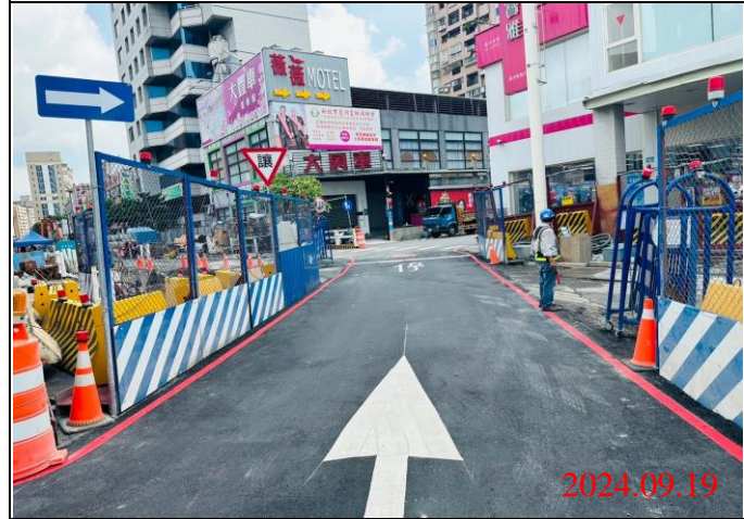
巡查日期地點：113.09.19/ Y21車站 照片說明：路面狀況
