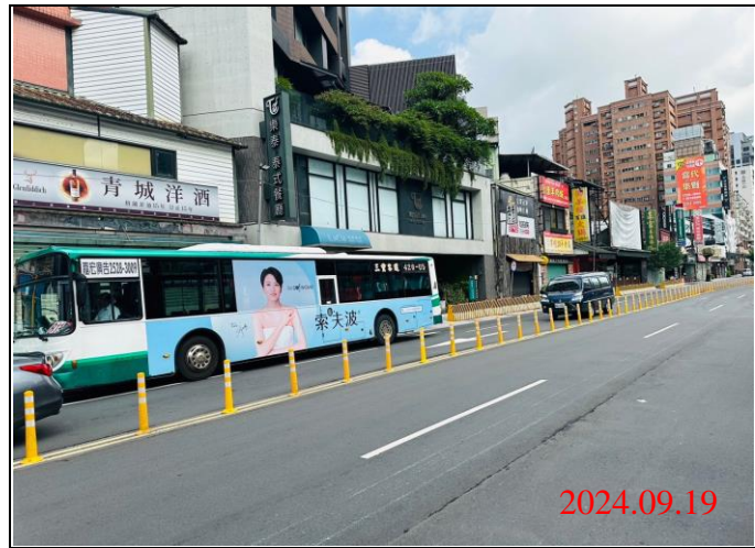
巡查日期地點：113.09.19/ Y21車站 照片說明：道路裂縫
