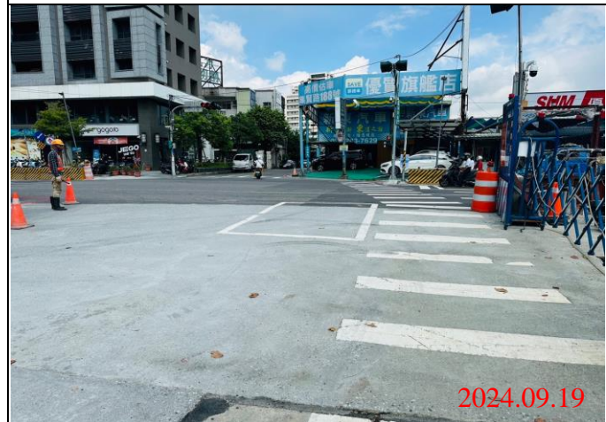
巡查日期地點：113.09.19/ Y22車站 照片說明：路面狀況
