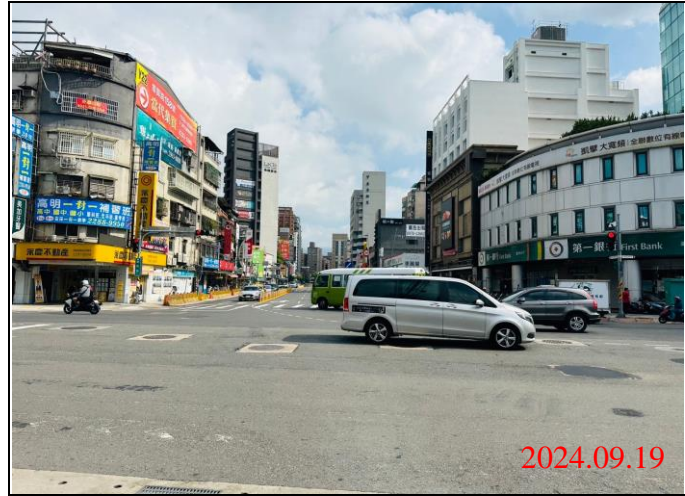
巡查日期地點：113.09.19/ Y21車站 照片說明：路面狀況
