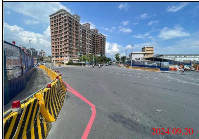
巡查日期地點：113.09.20/ Y22車站 照片說明：牌面設置狀況
