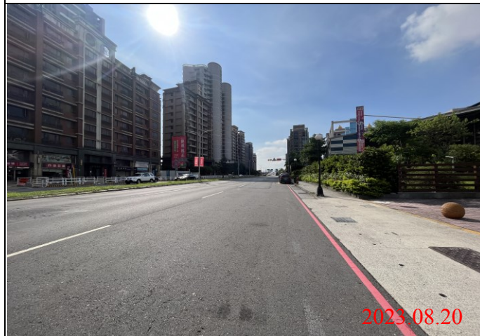
巡查日期地點：112.08.20/ Y23車站 照片說明：路面狀況
