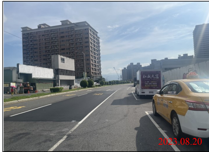
巡查日期地點：112.08.20/ Y22車站 照片說明：路面狀況
