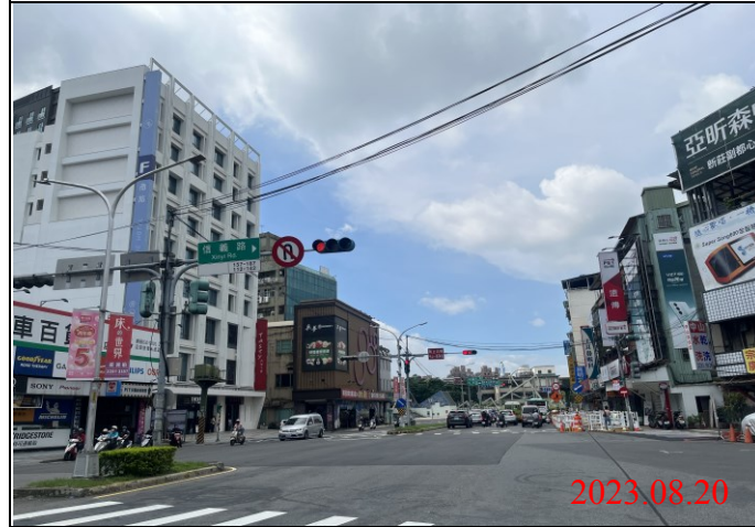
巡查日期地點：112.08.20/ Y21車站 照片說明：路面狀況
