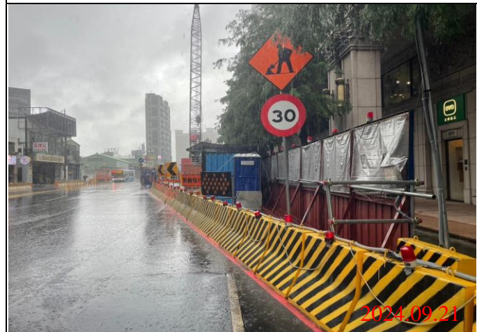
巡查日期地點：113.09.21/ Y22車站 照片說明：牌面設置狀況
