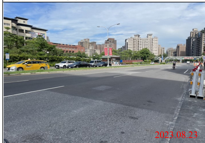
巡查日期地點：112.08.23/ Y23車站 照片說明：路面狀況
