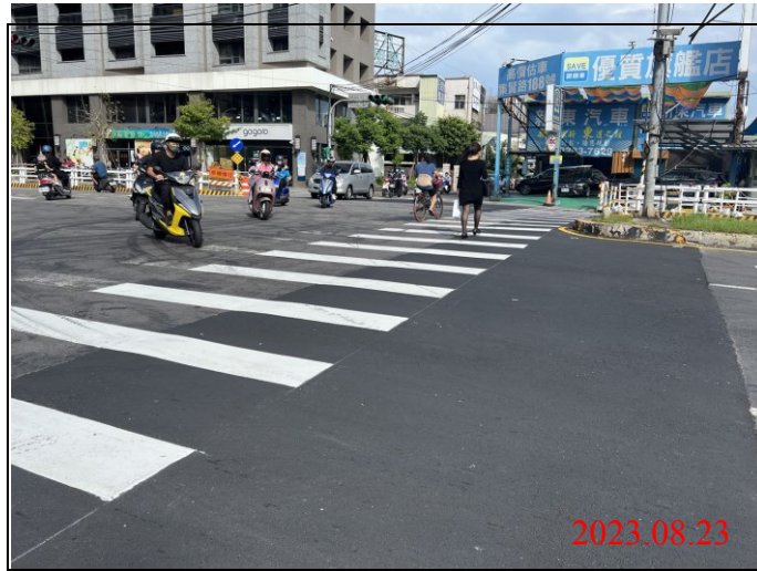
巡查日期地點：112.08.23/ Y23車站 照片說明：路面狀況
