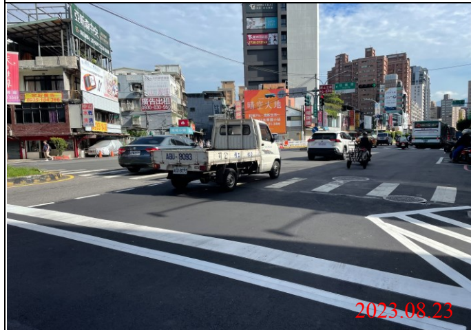
巡查日期地點：112.08.23/ Y21車站 照片說明：路面狀況
