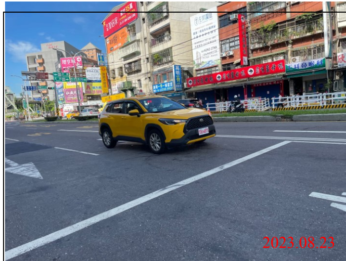
巡查日期地點：112.08.23/ Y21車站 照片說明：路面狀況
