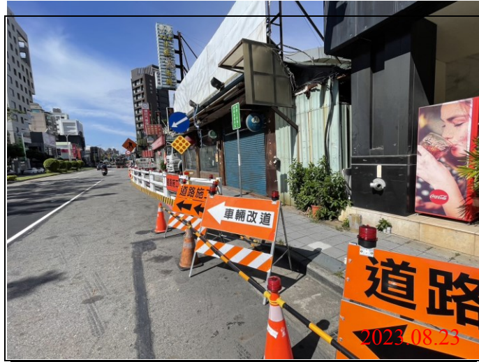
巡查日期地點：112.08.23/ Y21車站 照片說明：牌面設置狀況
