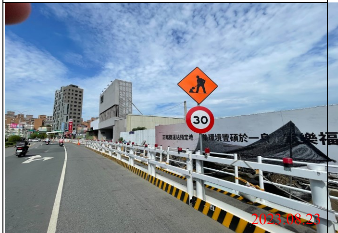
巡查日期地點：112.08.23/ Y23車站 照片說明：牌面設置狀況
