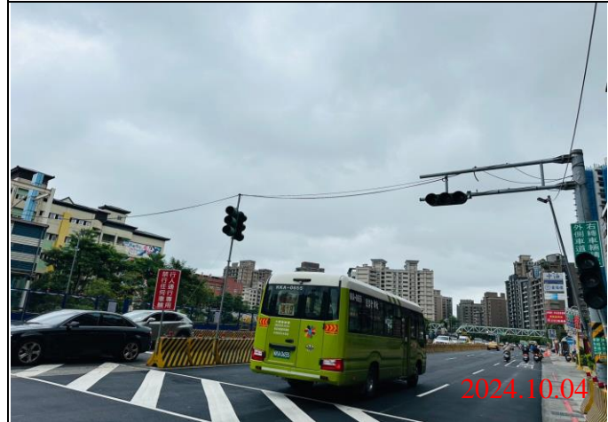
巡查日期地點：113.10.04/ Y23車站 照片說明：牌面設置狀況
