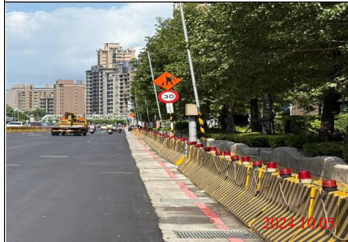
巡查日期地點：113.10.05/ Y23車站 照片說明：牌面設置狀況
