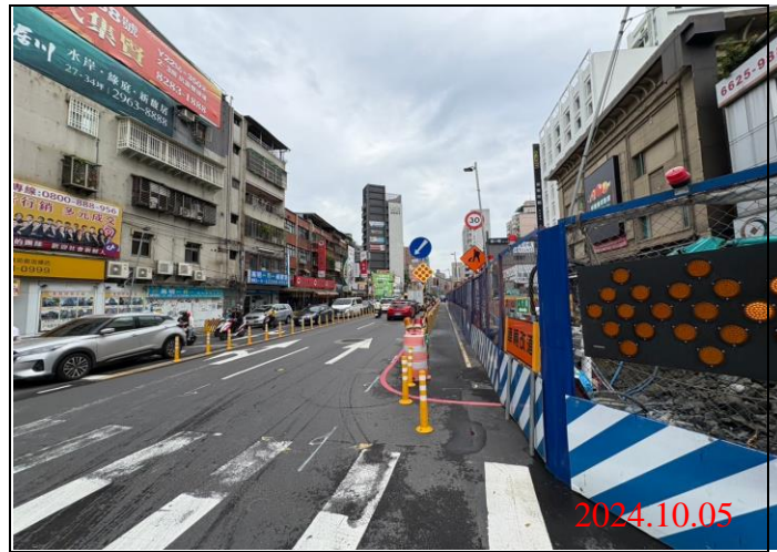
巡查日期地點：113.10.05/ Y21車站 照片說明：牌面設置狀況
