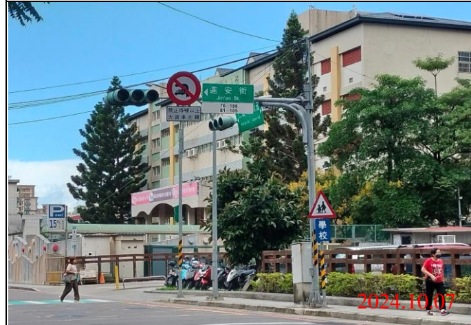
巡查日期地點：113.10.07 / Y23車站 照片說明：牌面設置狀況
