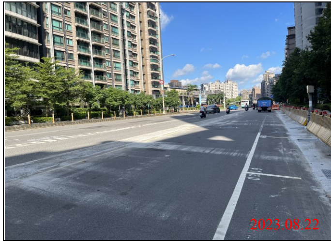
巡查日期地點：112.08.22/ Y23車站 照片說明：路面狀況
