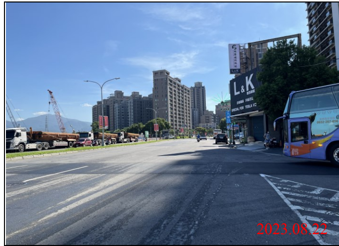
巡查日期地點：112.08.22/ Y22車站 照片說明：路面狀況
