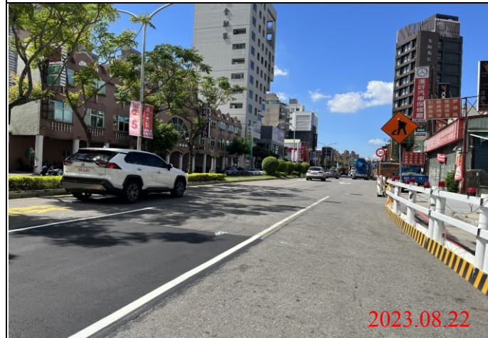
巡查日期地點：112.08.22/ Y21車站 照片說明：路面狀況
