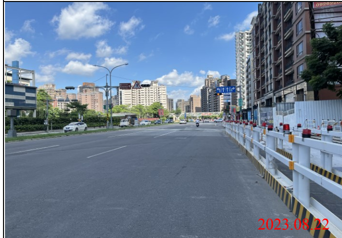
巡查日期地點：112.08.22/ Y23車站 照片說明：路面狀況
