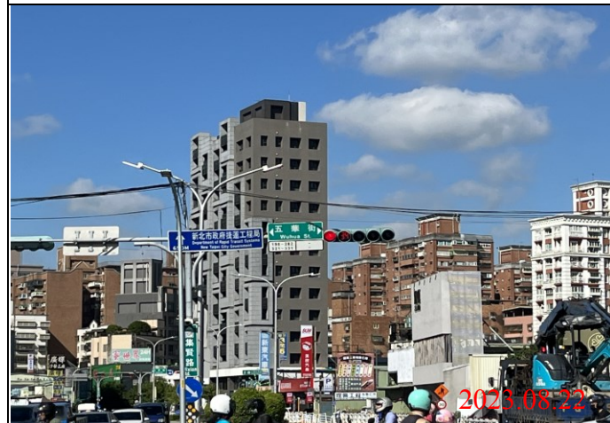
巡查日期地點：112.08.22/ Y22車站 照片說明：牌面設置狀況
