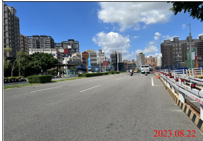
巡查日期地點：112.08.22/ Y22車站 照片說明：路面狀況
