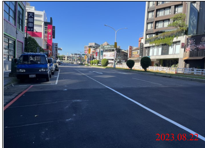
巡查日期地點：112.08.22/ Y21車站 照片說明：路面狀況
