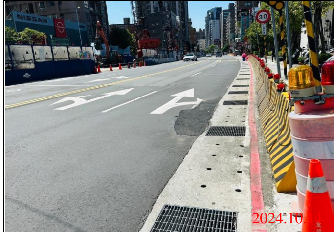
巡查日期地點：113.10.14/ Y22車站 照片說明：牌面設置狀況
