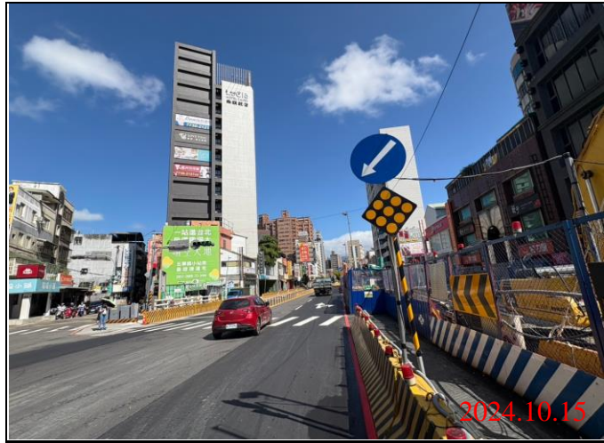
巡查日期地點：113.10.15/ Y21車站 照片說明：牌面設置狀況
