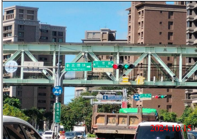
巡查日期地點：113.10.15/ Y23車站 照片說明：牌面設置狀況
