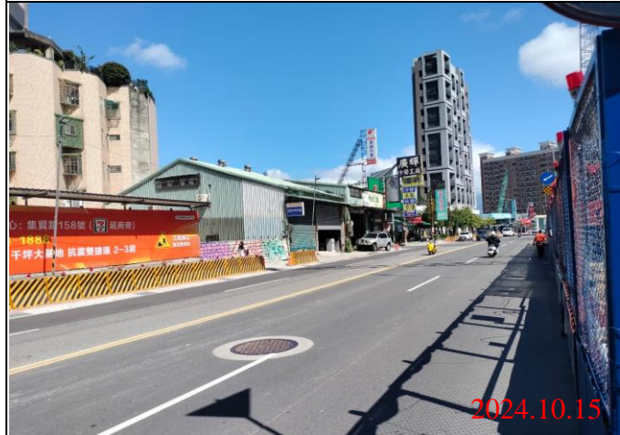
巡查日期地點：113.10.15/ Y22車站 照片說明：牌面設置狀況
