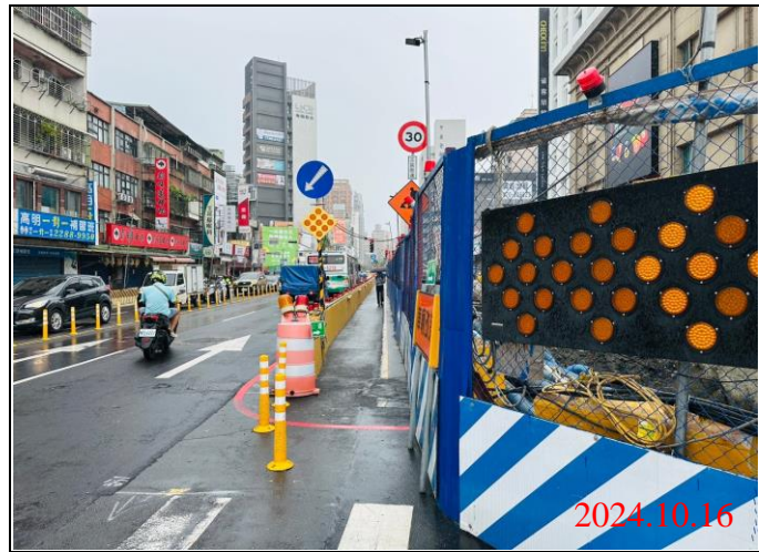
巡查日期地點：113.10.16/ Y21車站 照片說明：牌面設置狀況
