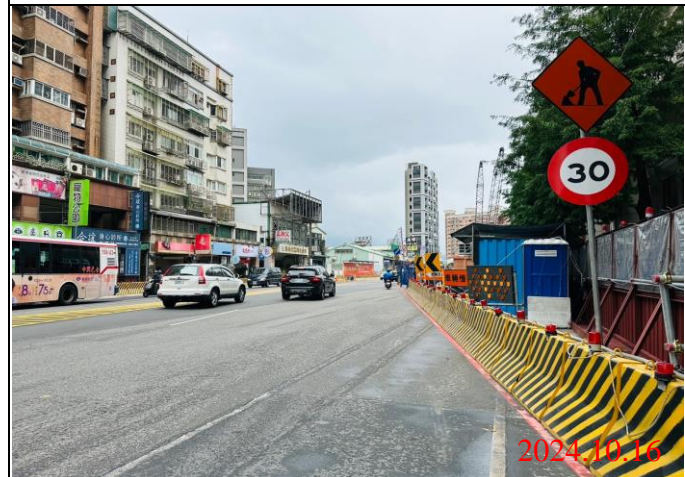
巡查日期地點：113.10.16/ Y22車站 照片說明：牌面設置狀況
