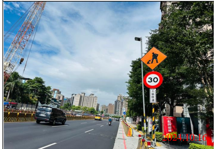
巡查日期地點：113.10.16/ Y23車站 照片說明：牌面設置狀況
