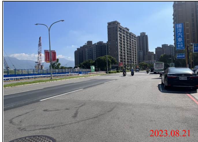
巡查日期地點：112.08.21/ Y22車站 照片說明：路面狀況
