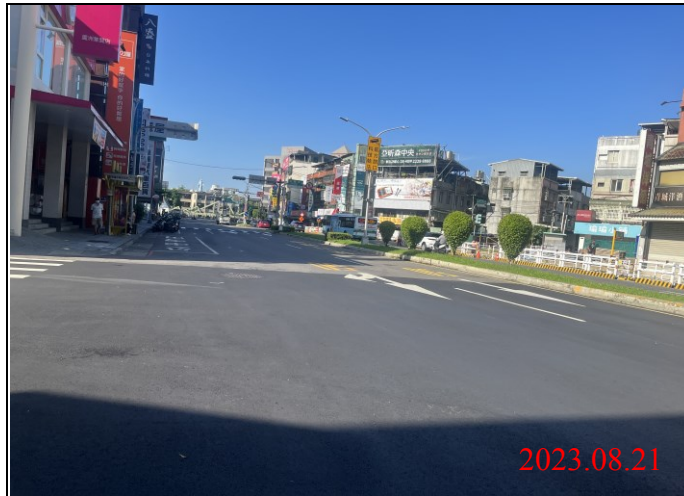
巡查日期地點：112.08.21/ Y21車站 照片說明：路面狀況
