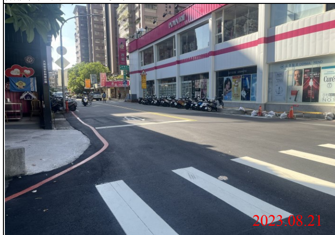
巡查日期地點：112.08.21/ Y21車站 照片說明：路面狀況
