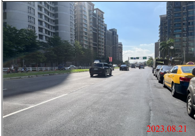
巡查日期地點：112.08.21/ Y23車站 照片說明：路面狀況
