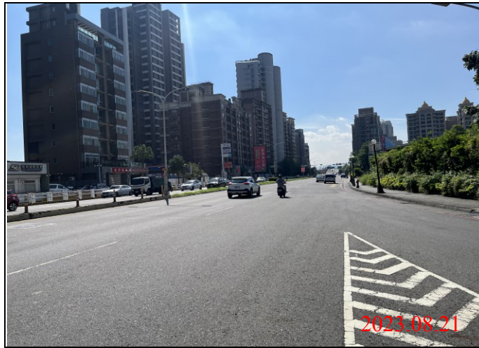
巡查日期地點：112.08.21/ Y23車站 照片說明：路面狀況
