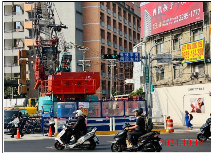
巡查日期地點：113.10.18/ Y21車站 照片說明：牌面設置狀況
