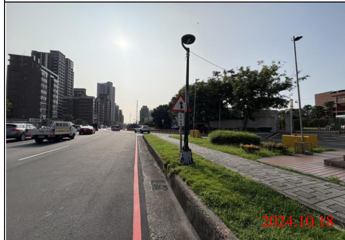
巡查日期地點：113.10.18/ Y23車站 照片說明：牌面設置狀況
