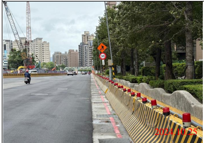
巡查日期地點：113.10.25/ Y23車站 照片說明：牌面設置狀況
