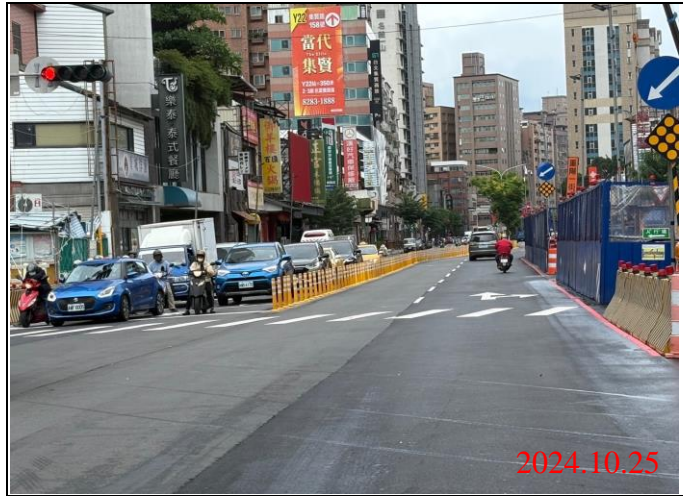
巡查日期地點：113.10.25/ Y21車站 照片說明：牌面設置狀況
