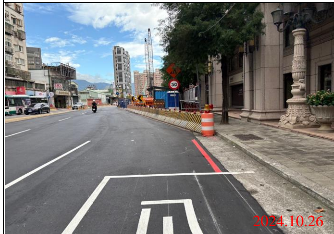
巡查日期地點：113.10.26/ Y22車站 照片說明：牌面設置狀況
