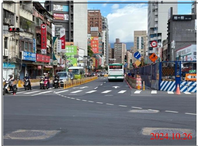
巡查日期地點：113.10.26/ Y21車站 照片說明：牌面設置狀況
