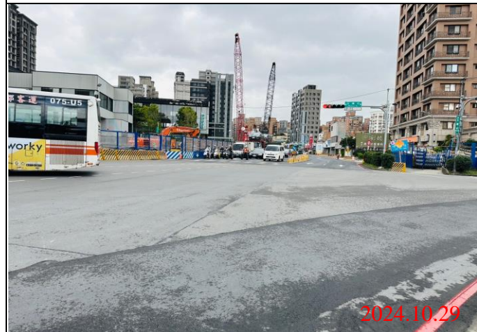
巡查日期地點：113.10.29/ Y22車站 照片說明：牌面設置狀況
