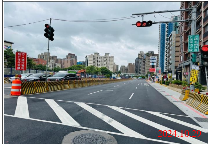
巡查日期地點：113.10.29/ Y23車站 照片說明：牌面設置狀況
