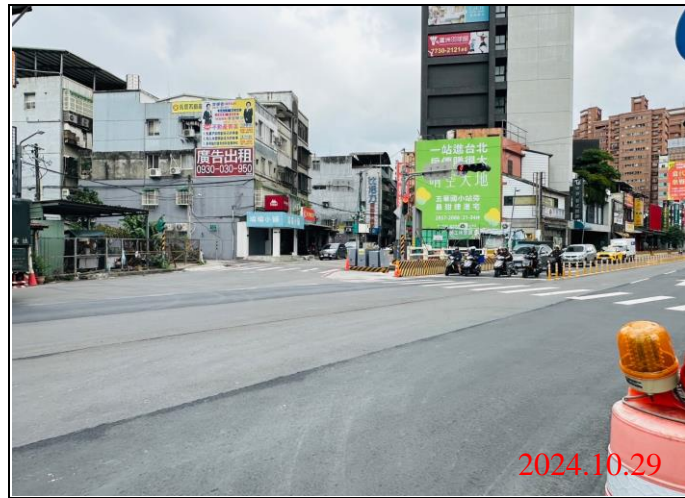
巡查日期地點：113.10.29/ Y21車站 照片說明：牌面設置狀況
