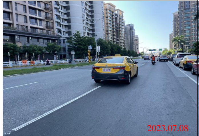
巡查日期地點：112.07.08/ Y23車站 照片說明：路面狀況
