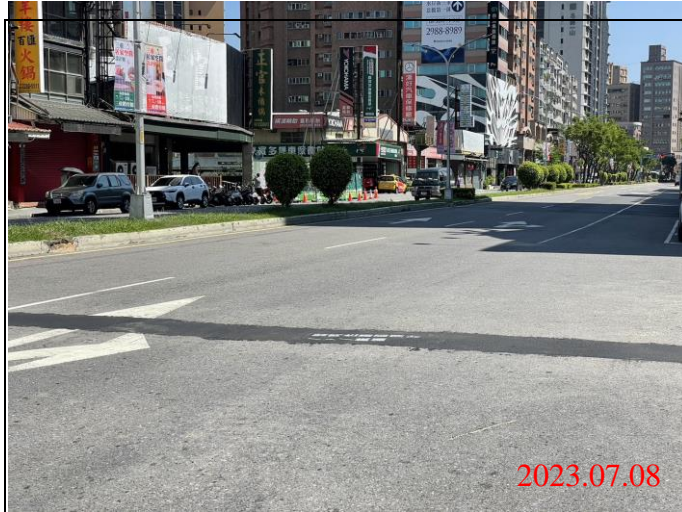
巡查日期地點：112.07.08/ Y21車站 照片說明：路面狀況
