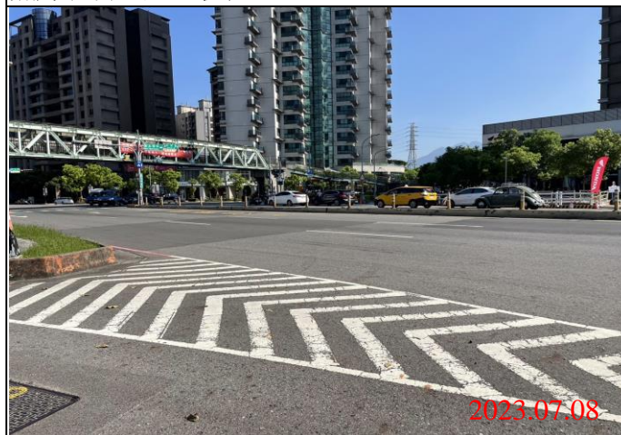
巡查日期地點：112.07.08/ Y23車站 照片說明：路面狀況
