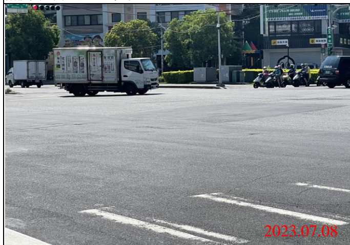
巡查日期地點：112.07.08/ Y22車站 照片說明：路面狀況
