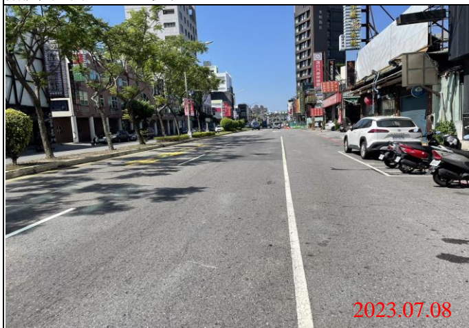
巡查日期地點：112.07.08/ Y21車站 照片說明：路面狀況
