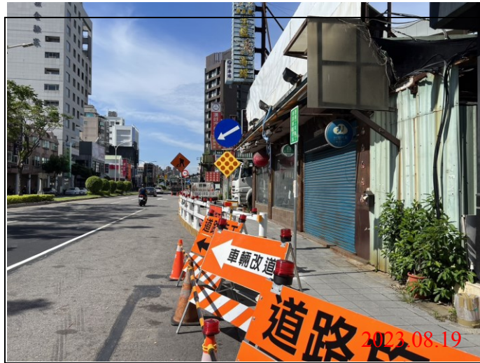
巡查日期地點：112.08.19/ Y21車站 照片說明：牌面設置狀況
