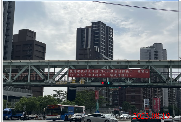
巡查日期地點：112.08.19/ Y23車站 照片說明：牌面設置狀況
