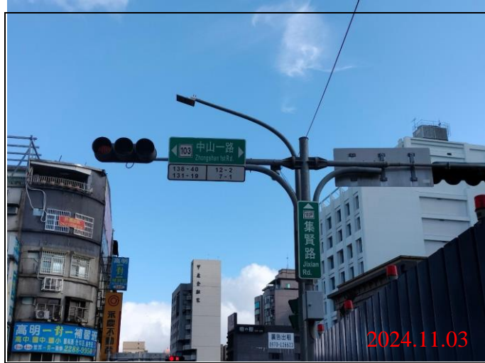
巡查日期地點：113.11.03/ Y21車站 照片說明：牌面設置狀況
