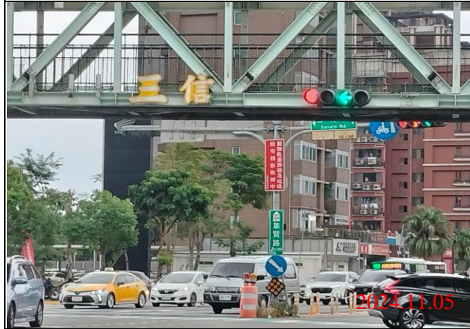
巡查日期地點：113.11.05 Y23車站 照片說明：牌面設置狀況
