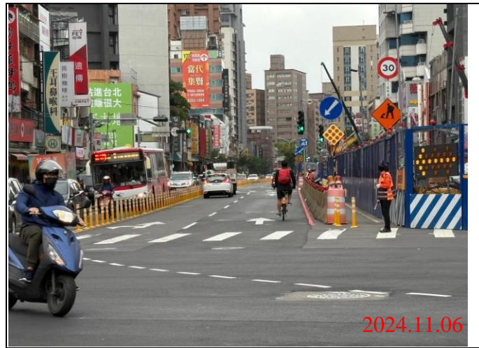
巡查日期地點：113.11.06 /Y21車站 照片說明：牌面設置狀況
