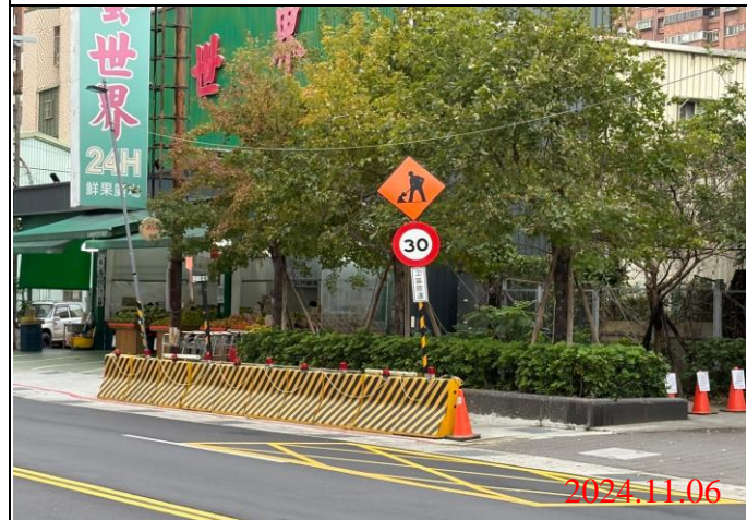
巡查日期地點：113.11.06 /Y22車站 照片說明：牌面設置狀況
