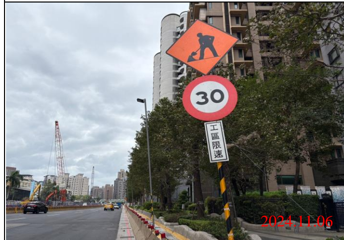
巡查日期地點：113.11.06 /Y23車站 照片說明：牌面設置狀況
