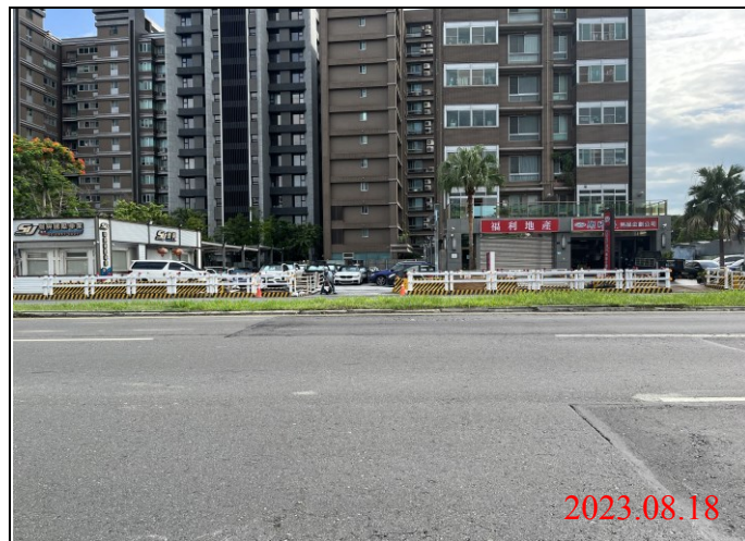
巡查日期地點：112.08.18/ Y23車站 照片說明：路面龜裂狀況
