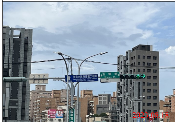
巡查日期地點：112.08.18/ Y22車站 照片說明：牌面設置狀況
