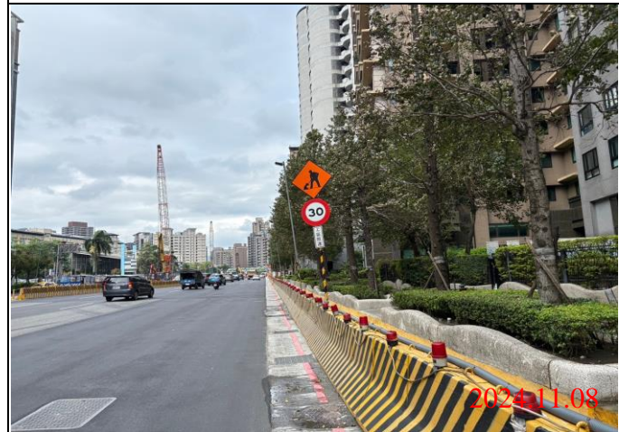
巡查日期地點：113.11.08 /Y23車站 照片說明：牌面設置狀況
