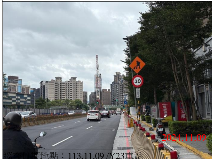
巡查日期地點：113.11.09 /Y22車站 照片說明：牌面設置狀況
