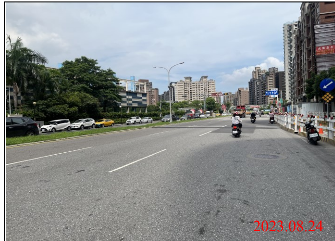
巡查日期地點：112.08.24/ Y23車站 照片說明：路面狀況
