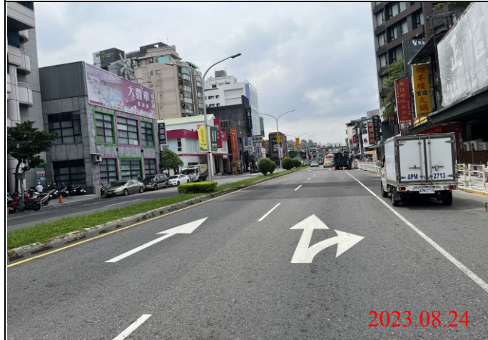
巡查日期地點：112.08.24/ Y21車站 照片說明：路面狀況
