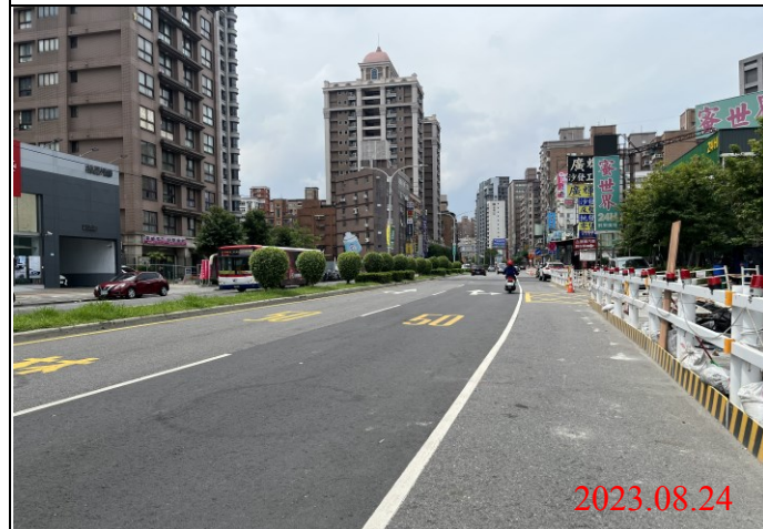
巡查日期地點：112.08.24/ Y22車站 照片說明：路面狀況
