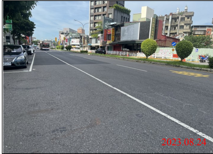
巡查日期地點：112.08.24/ Y21車站 照片說明：路面狀況
