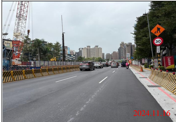
巡查日期地點：113.11.16/ Y23車站 照片說明：牌面設置狀況
