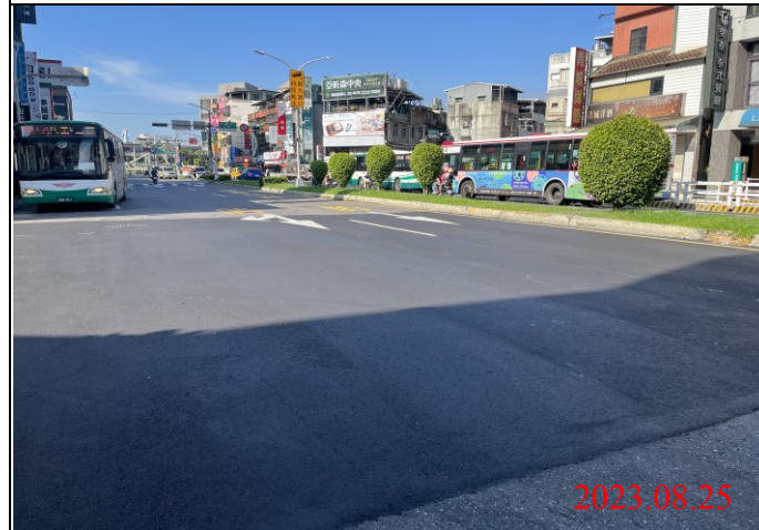
巡查日期地點：112.08.25/ Y21車站 照片說明：路面狀況
