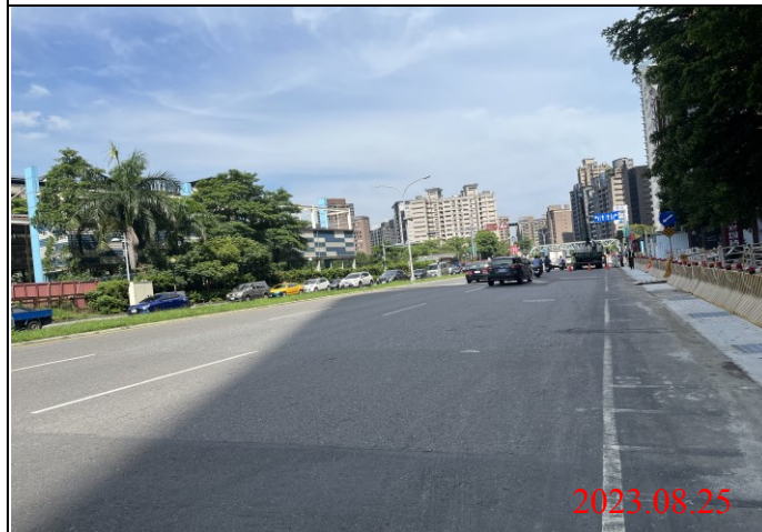
巡查日期地點：112.08.25/ Y23車站 照片說明：路面狀況
