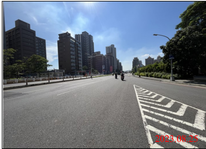
巡查日期地點：112.08.25/ Y23車站 照片說明：路面狀況
