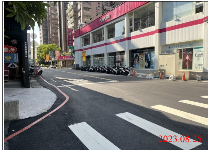
巡查日期地點：112.08.25/ Y21車站 照片說明：路面狀況
