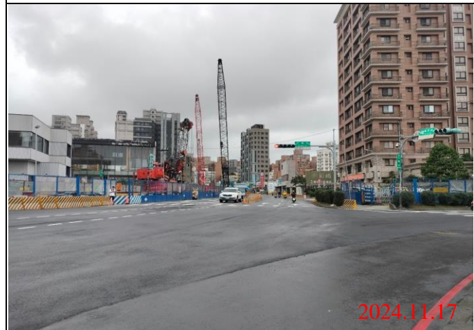
巡查日期地點：113.11.17/ Y22車站 照片說明：牌面設置狀況
