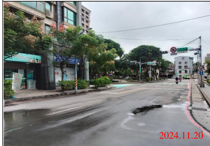
巡查日期地點：113.11.20/ Y23車站 照片說明：牌面設置狀況
