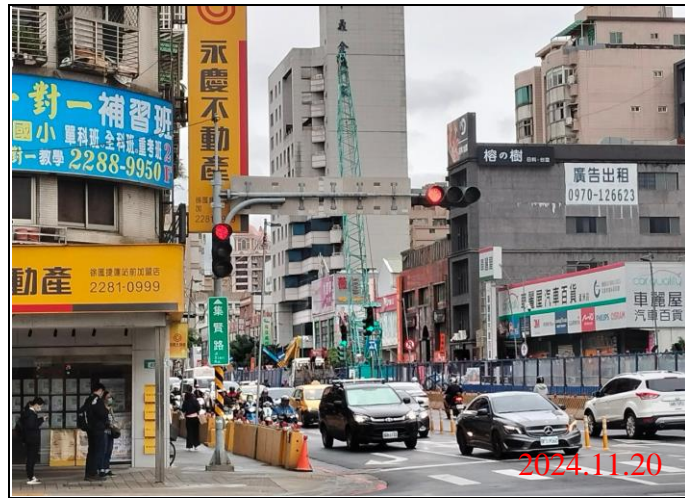
巡查日期地點：113.11.20/ Y21車站 照片說明：牌面設置狀況
